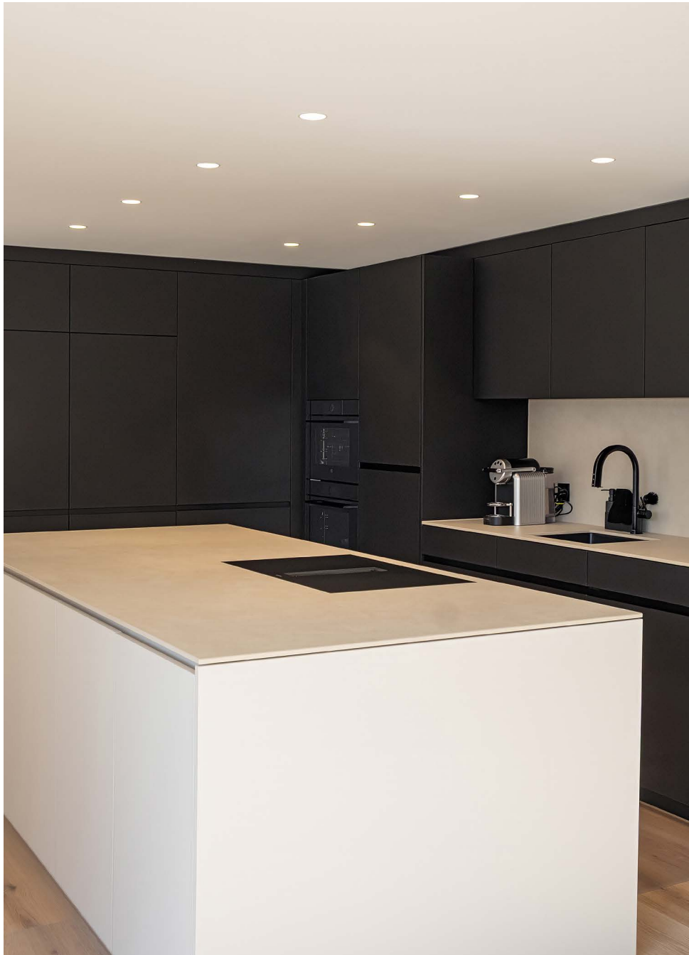
Einbauleuchten in der Küche eines Einfamilienhauses, Niederbipp | ©AKA Leuchten AG
