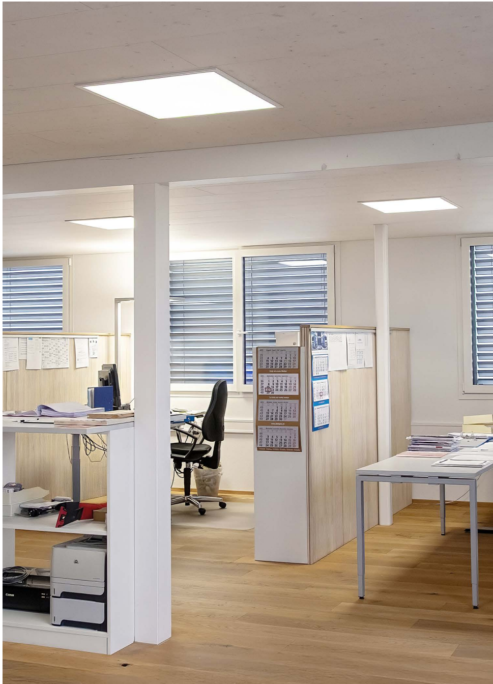
LED Panel EUROPE im Büro der Schärli Holzbau AG, Deitingen | ©AKA Leuchten AG
