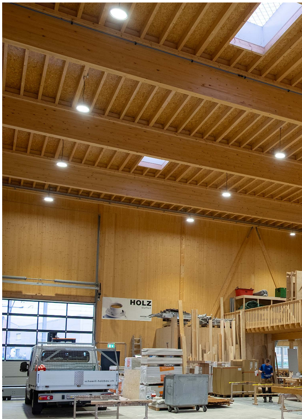
Hallenstrahler GRANIT bei der Schärli Holzbau AG, Deitingen | ©AKA Leuchten AG
